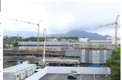
建設工事の中の上牧中学校新校舎（令和7年）
