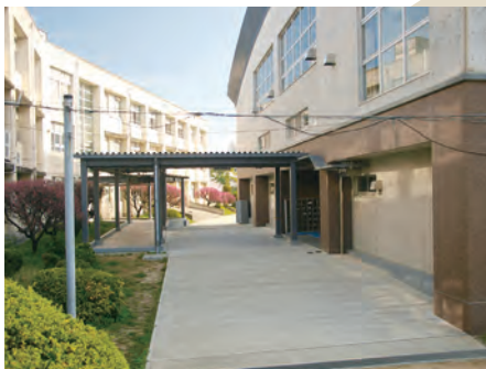
「2015年頃 校舎と体育館をつなぐ渡り廊下」 多くの生徒が行き交った
