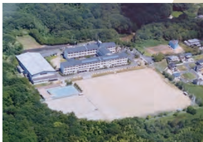
「太陽光パネル」 平成22年4月 国のスクールニューディール構想により、設置
