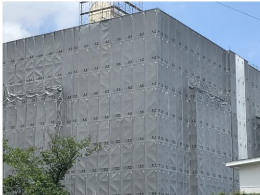
足場防音シート張り
