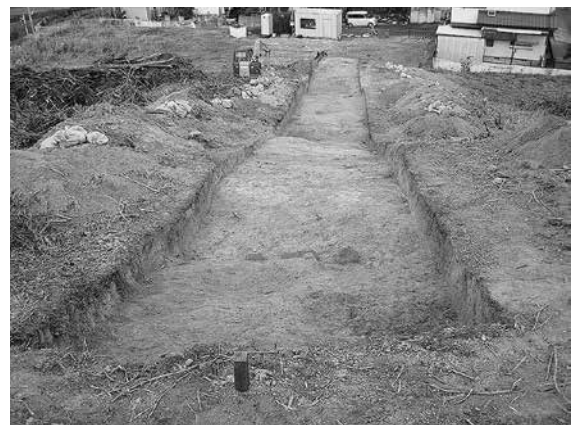
写真6 第3トレンチ全景（南西より）
