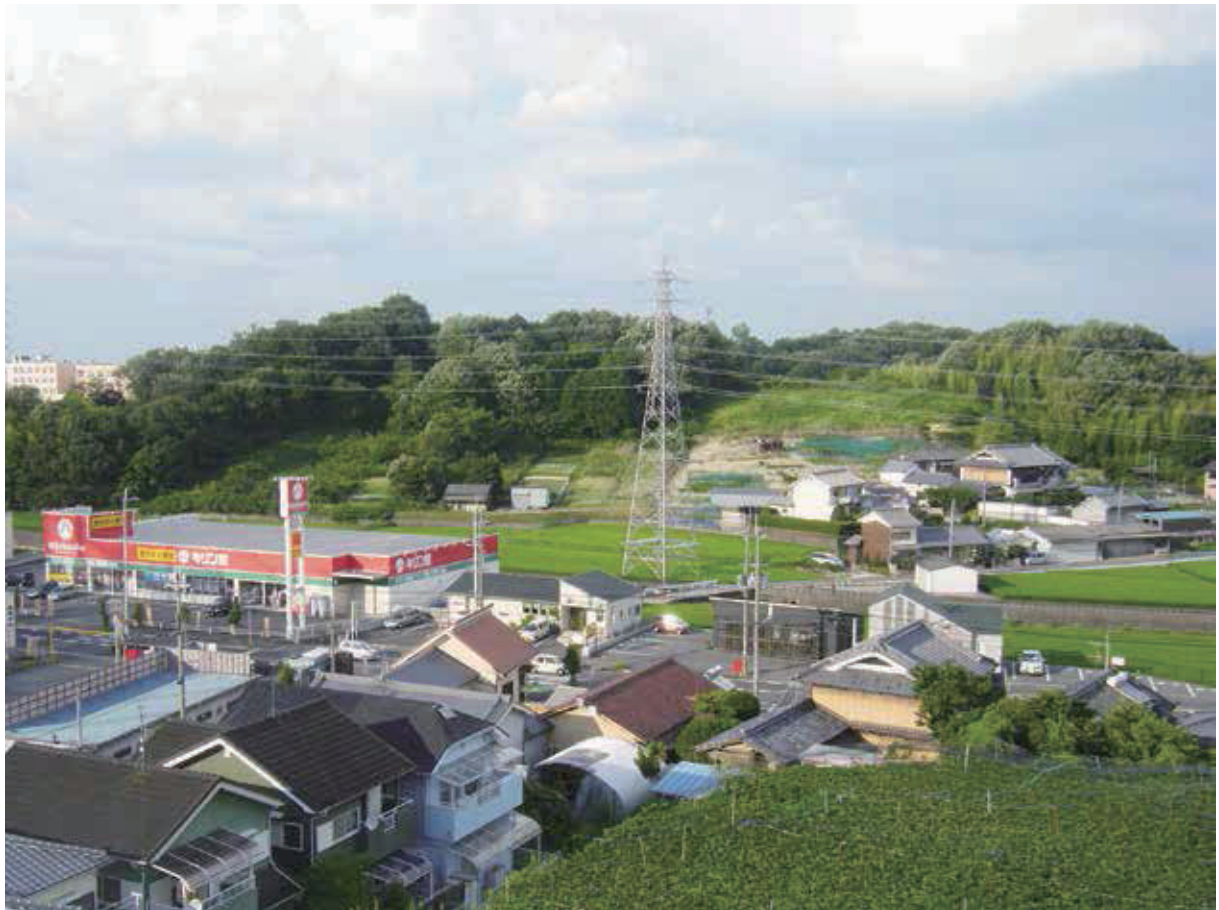
調査地遠景（南西より）
