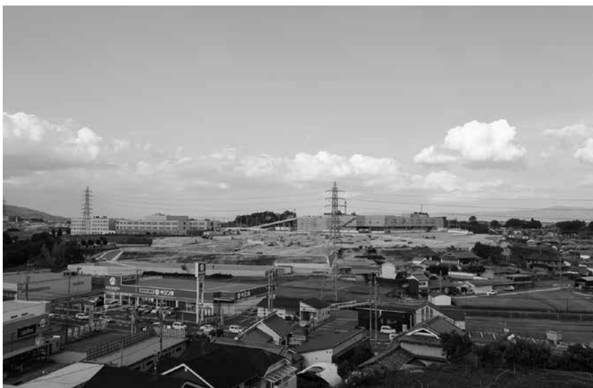
調査終了後の状況（南西より） 平成25年9月撮影
