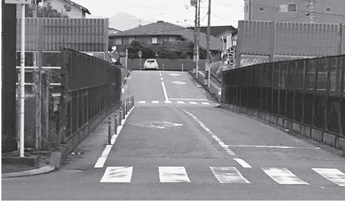
今回改修が行われる岡在橋
