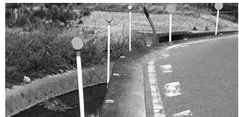
脱輪防止・視線誘導標(反射板)の設置例
