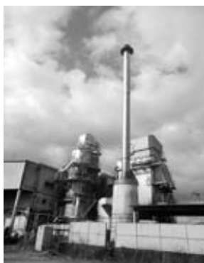
撤去予定の焼却場煙突
