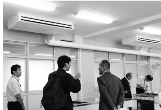
エアコン設置状況視察
