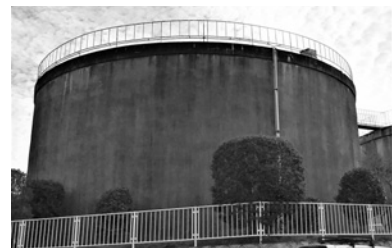
上牧町給水タンク
