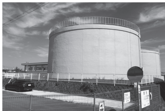
上牧町給水タンク
