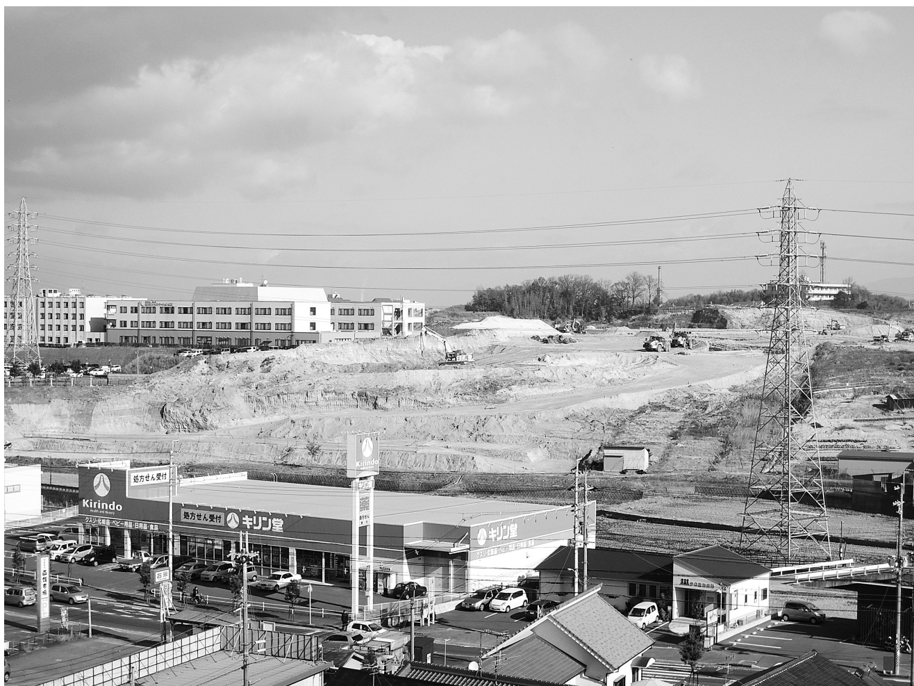
三軒屋開発(役場屋上より)
