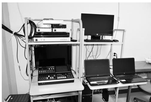
インターネット中継の設備
