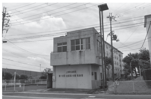
49年経過した現在の消防屯所
