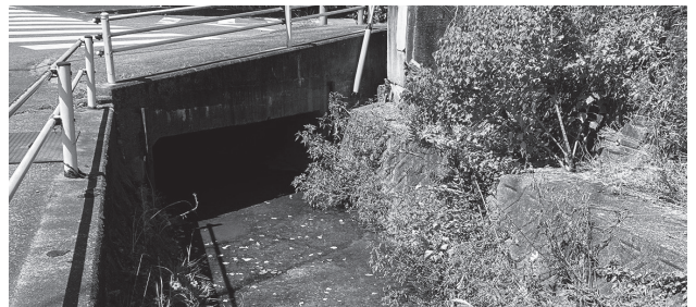
*ボックスカルバート…地中に埋設されたコンクリートの水路
