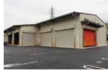
▲不燃ごみ等中継施設が完成しました
