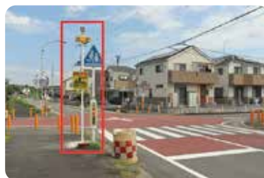
横断歩道に設置された注意喚起灯(赤枠内)
