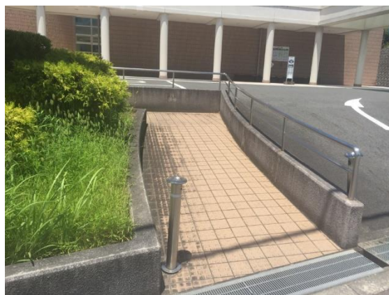
図 3-19 2000 年会館入口のスロープ
