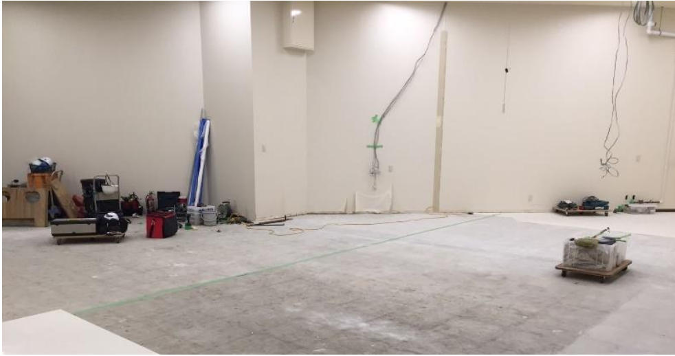
【図 03 改装中の店舗(面積 : 145m 2 )】
