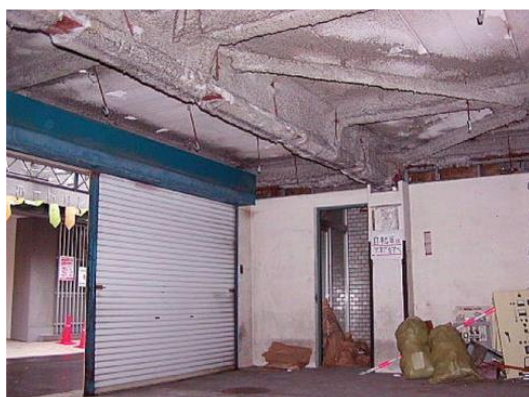
吹付アスベスト等が飛散し、暴露する可能性が高い
