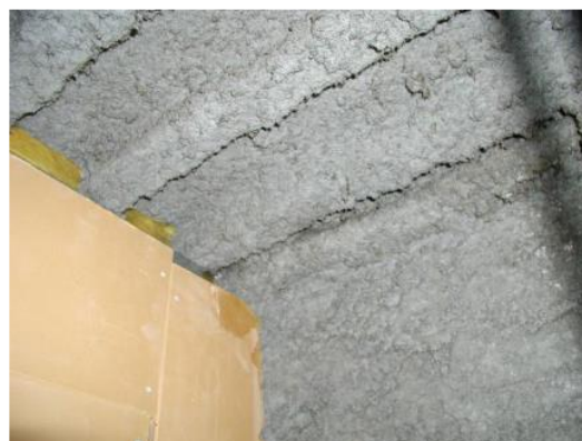
吹付アスベスト等が飛散し、暴露する可能性が高い
